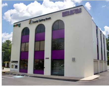
2095 CHAIN BRIDGE RD Vienna, VA 22182
